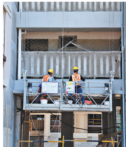
工人们正在紧张有序地作业。
