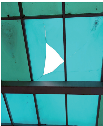
■天桥遮雨棚“开天窗”。
