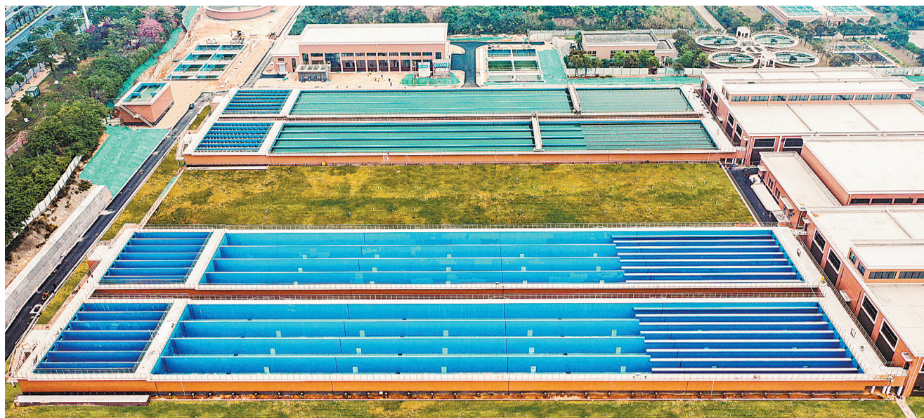
海沧水厂三期工程近日与一期、二期正式并网通水。图为海沧水厂三期的生产设施。(本报记者 王协云 摄)
