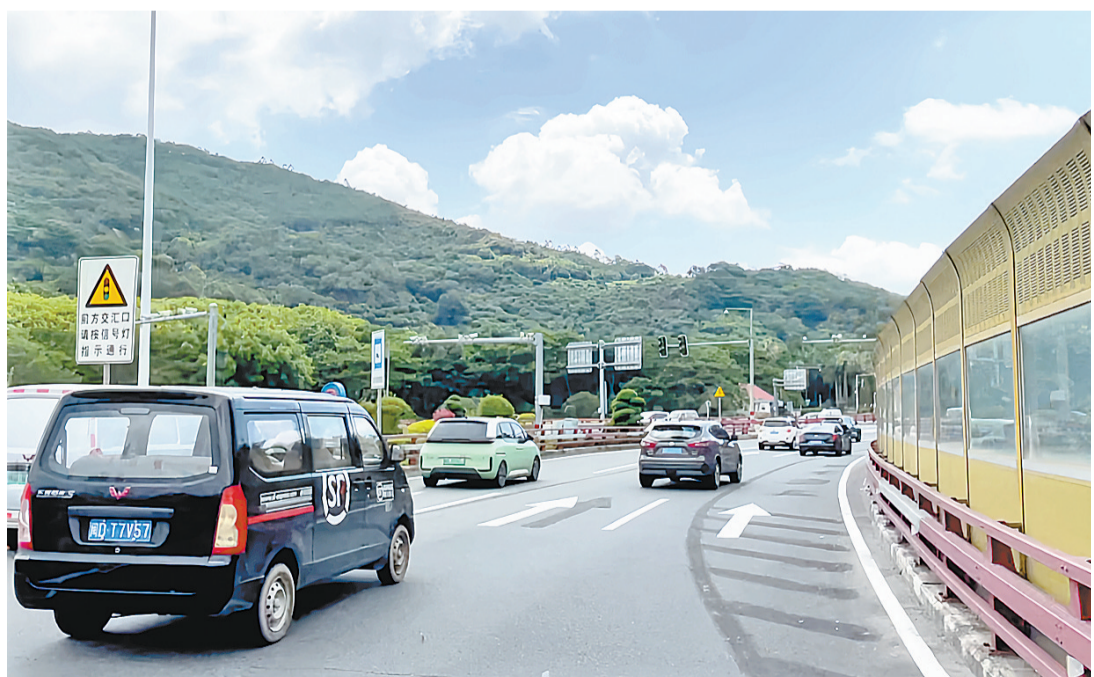
石塘立交马青路进岛交会段利用应急车道空间,增设1条行车道,将交会段车道调整为3车道,提升通行能力。
