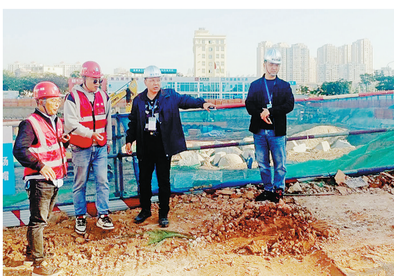
市城管办持续开展道路扬尘、工地扬尘等常态考评。
