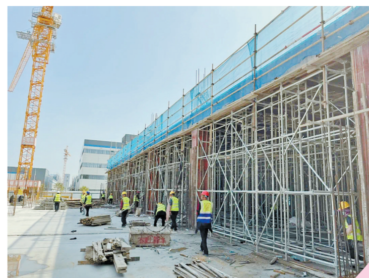
▲ 正在建设中的力品药业创新制剂国际化总部项目。（海沧区供图）
